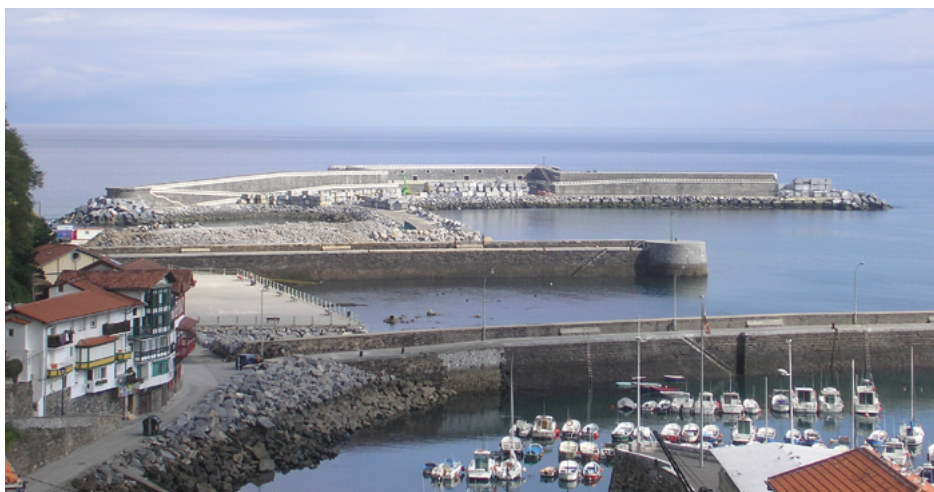
3. Photo du port de Mutriku (Espagne). En arrière plan, au milieu de la digue, une centrale houlomotrice, basée sur le principe de la « colonne d'eau oscillante », produit de l'électricité depuis 2011.
