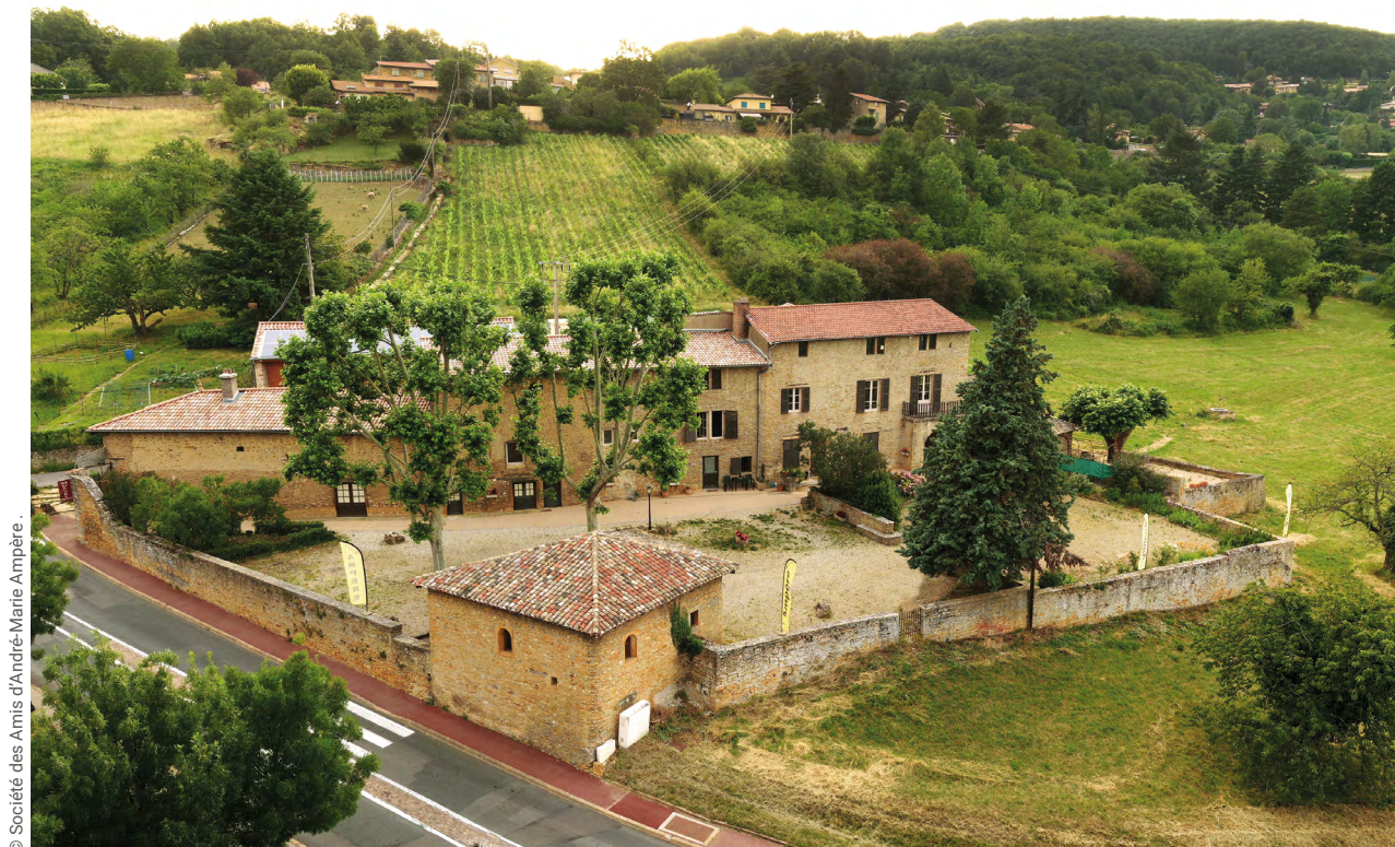
La Maison d'Ampère - Musée de l'électricité et des énergies à Poleymieux-au-Mont-d'Or.
