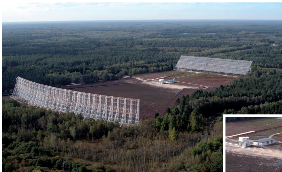
5. Photo aérienne du grand radiotélescope de Nançay. À droite, le miroir mobile est orientable selon un axe horizontal qui permet d'observer plus ou moins haut dans le ciel. Après cette première réflexion, les ondes sont réfléchies et concentrées par le miroir fixe à gauche, avant d'être détectées par l'un des récepteurs situés sur le chariot mobile de 40 tonnes au centre sur la voie ferrée (voir zoom).
