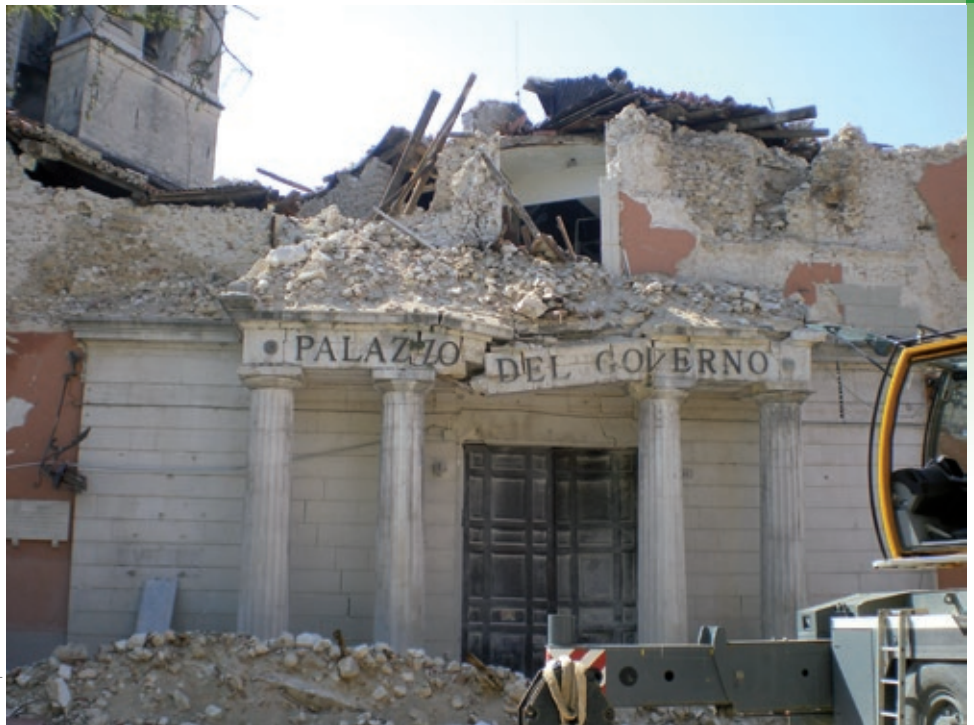
La préfecture de L'Aquila après le séisme, un symbole de la destruction.
