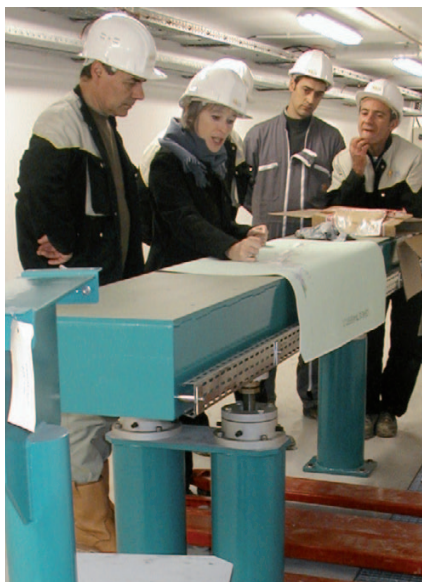
Marie-Agnès Tordeux (2 e à partir de la gauche) et l'équipe des mécaniciens du synchrotron, au printemps 2005, lors de l'installation des premières poutres supports de la machine dans le tunnel du LINAC, injecteur de SOLEIL.
