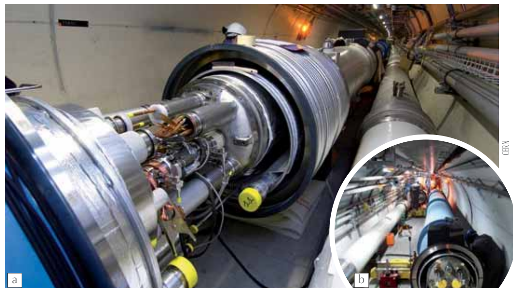
1. Construction du collisionneur. (a) Réalisation de la première interconnexion entre deux cryoaimants. (b) Le 1000 e cryoaimant supraconducteur en place (5 septembre 2006) : les deux taches jaunes contiguës sont des bouchons sur les deux tubes à vide où passeront les faisceaux ; juste au-dessus (et en dessous à gauche), les câbles supraconducteurs, prêts à être connectés à l'aimant suivant.
