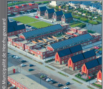
Panneaux photovoltaïques sur les toits de la « Cité du Soleil », Heerhugowaard (près d'Alkmaar), Pays-Bas.
